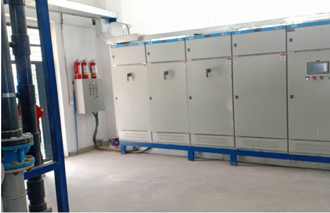
杜瓦联合水厂新建净水间
