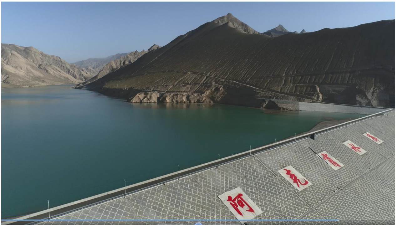
建成后的水库后坝全貌
