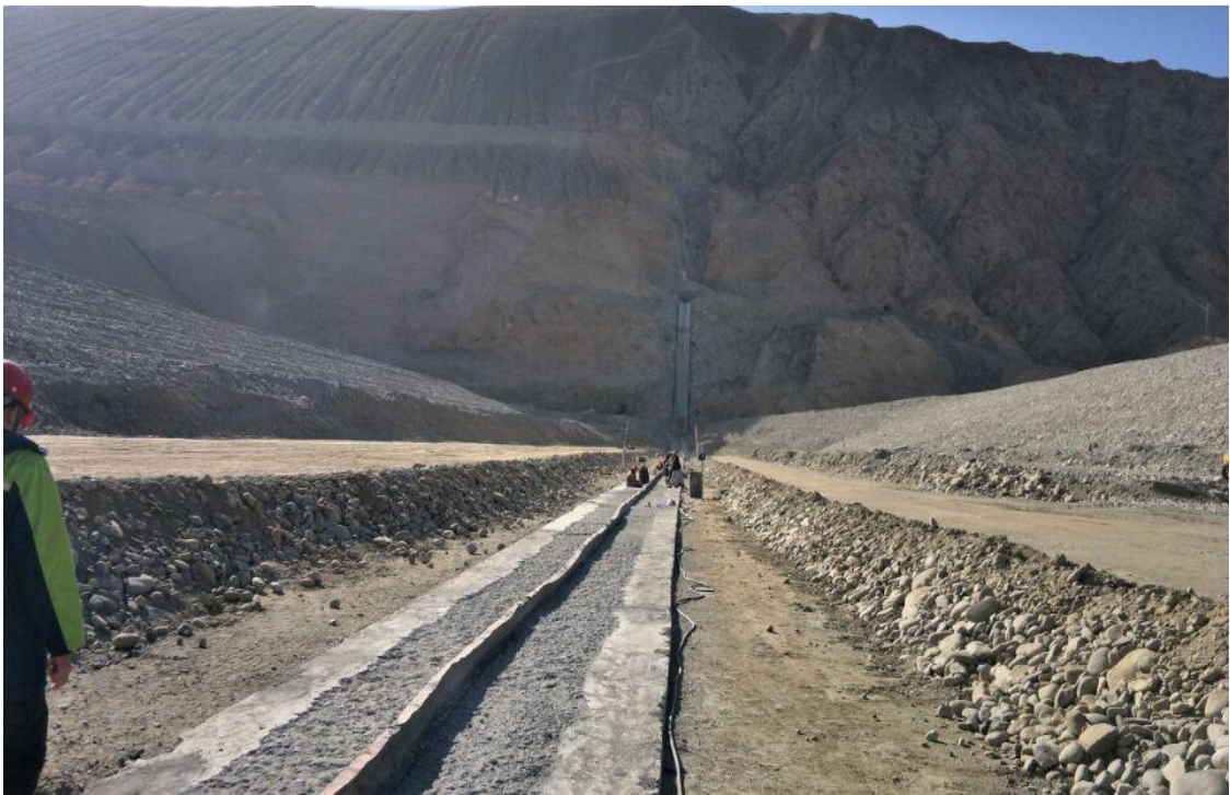
施工中的沥青心墙坝
