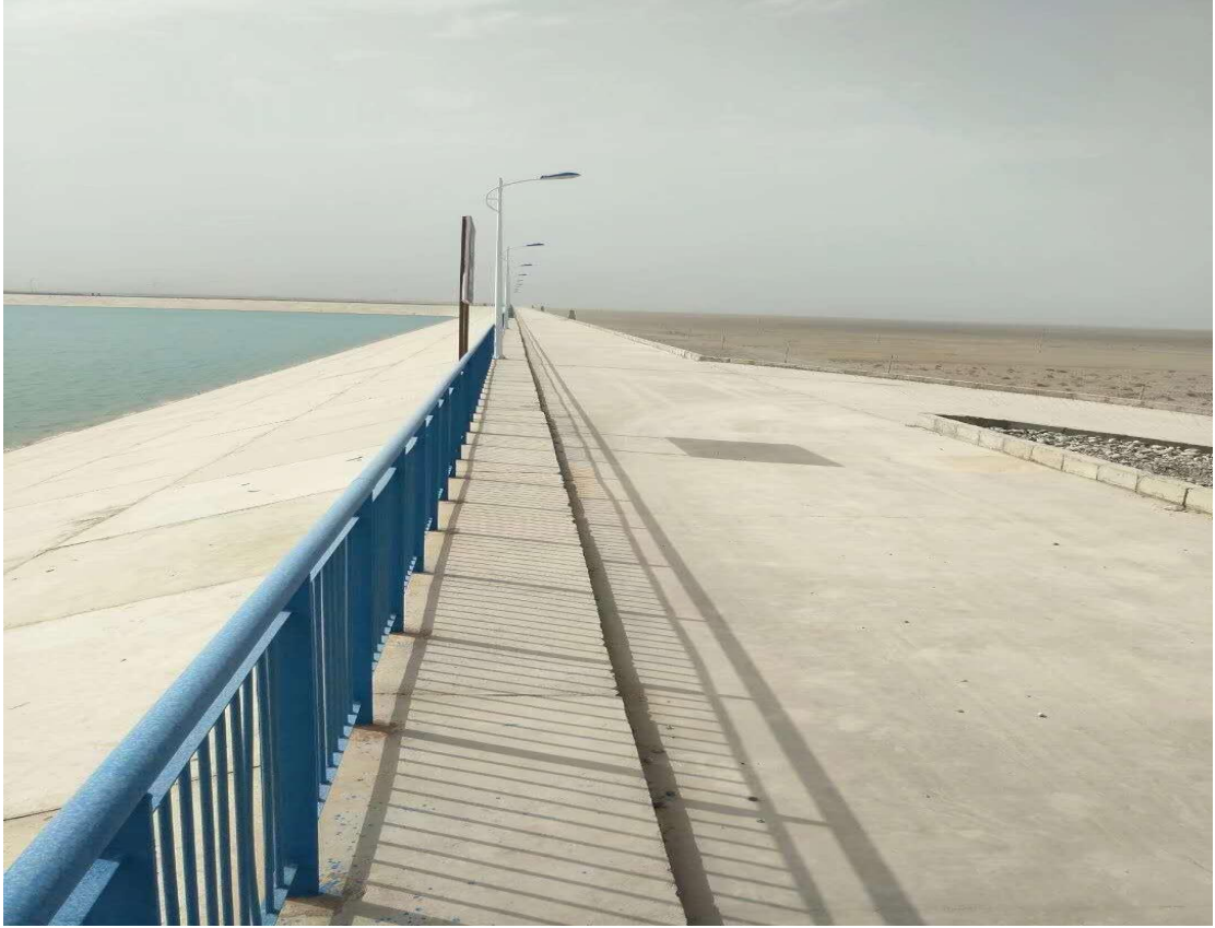
水库混凝土面板及坝顶道路
