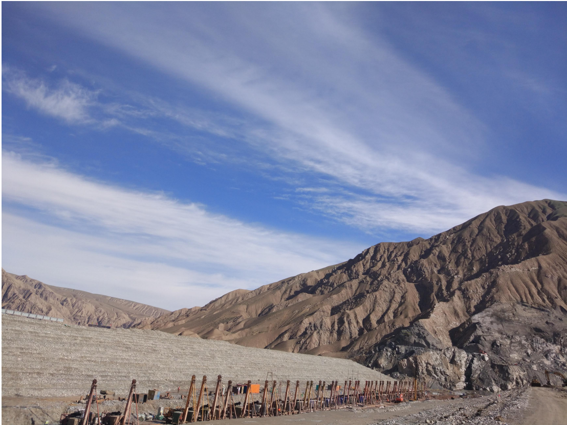
施工中的水库基础
