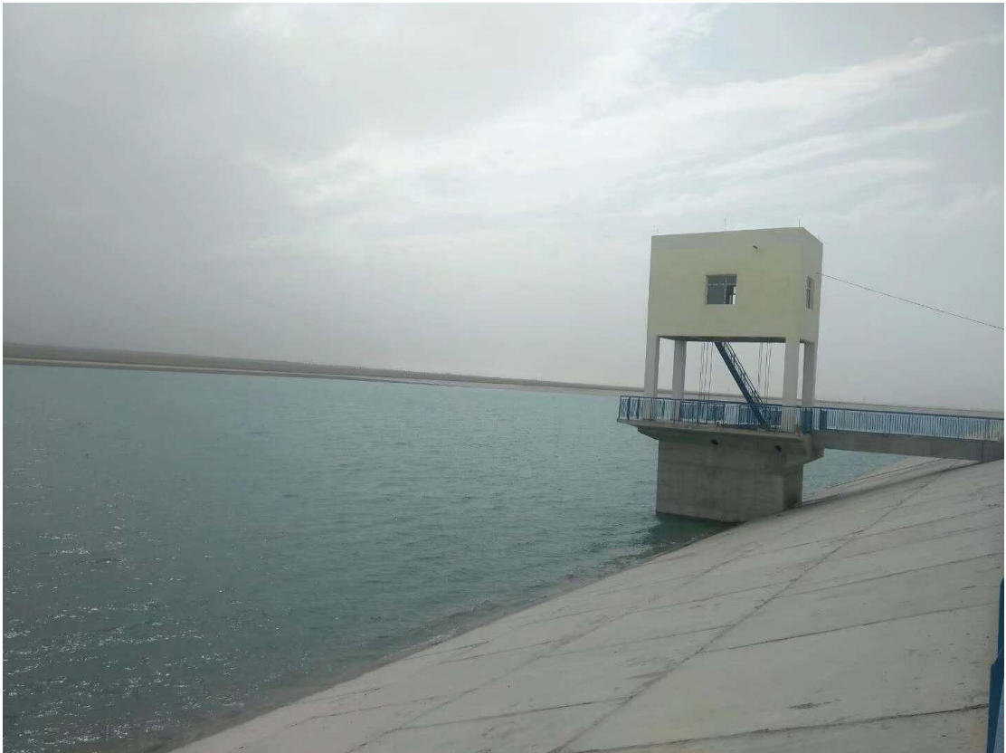
水库蓄水全貌及闸门照片
