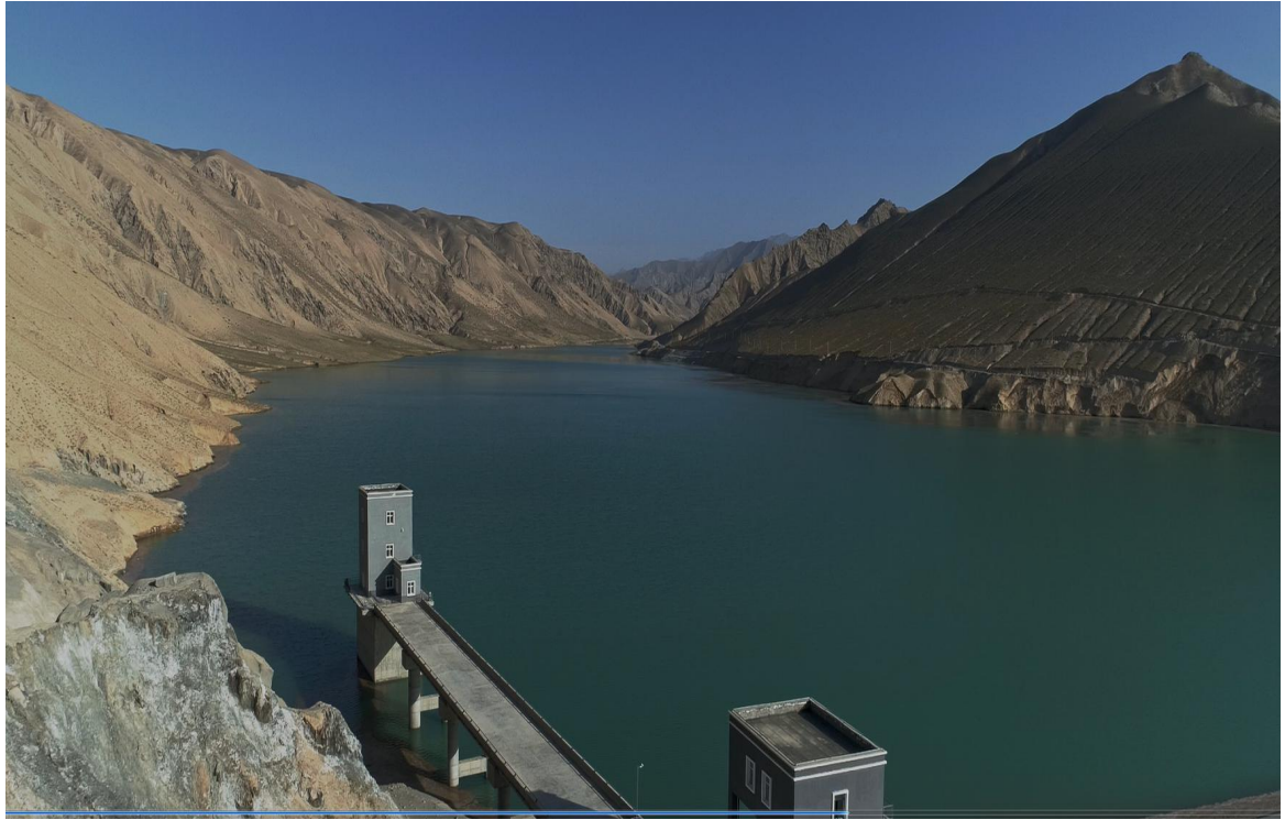
建成后的导流兼泄洪冲砂洞全貌
