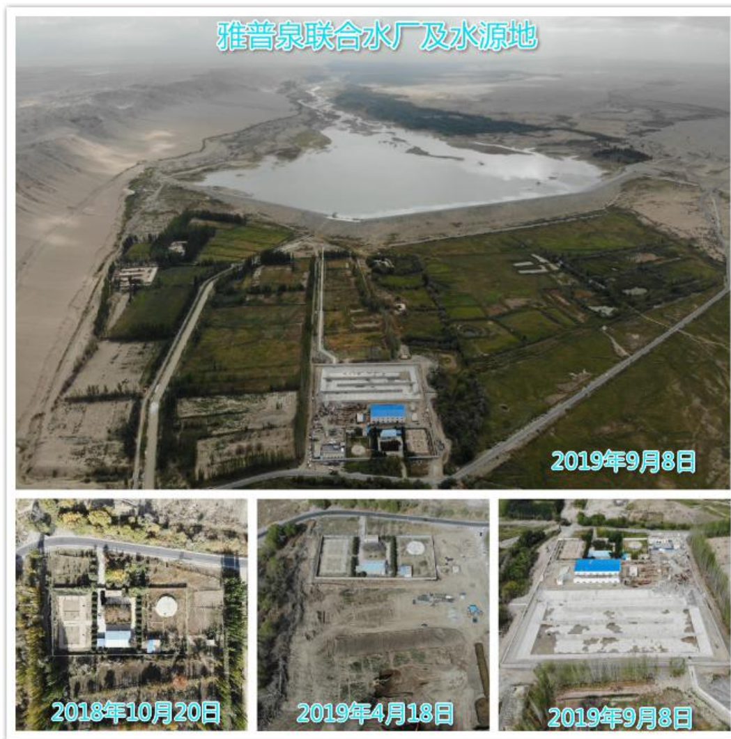
雅普泉水厂航拍图
