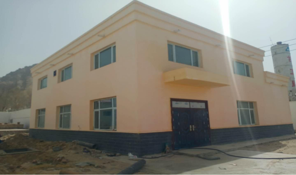
克里阳联合水厂新建净水车间
