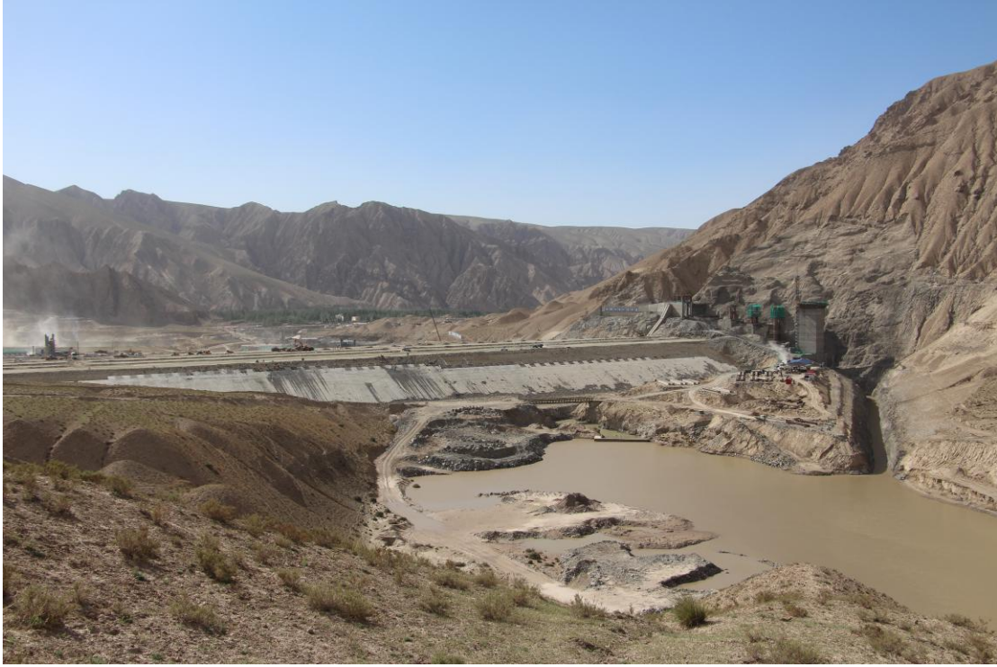
施工中的水库全貌
